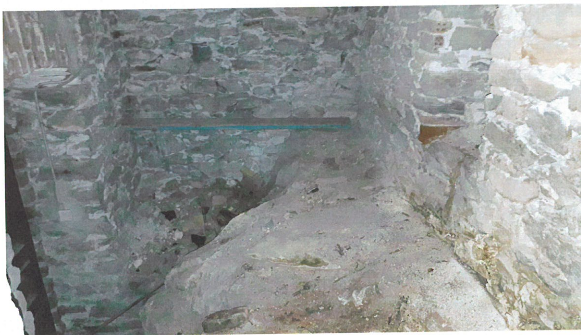
Φωτ.2: Επιφανειακή εμφάνιση του βράχου στο υπόγειο ( Μέγαρο Wix )
