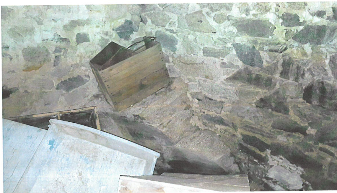
Φωτ.5: Επιφανειακή εμφάνιση του βράχου στο υπόγειο (Κτίριο Μούτουλα)
