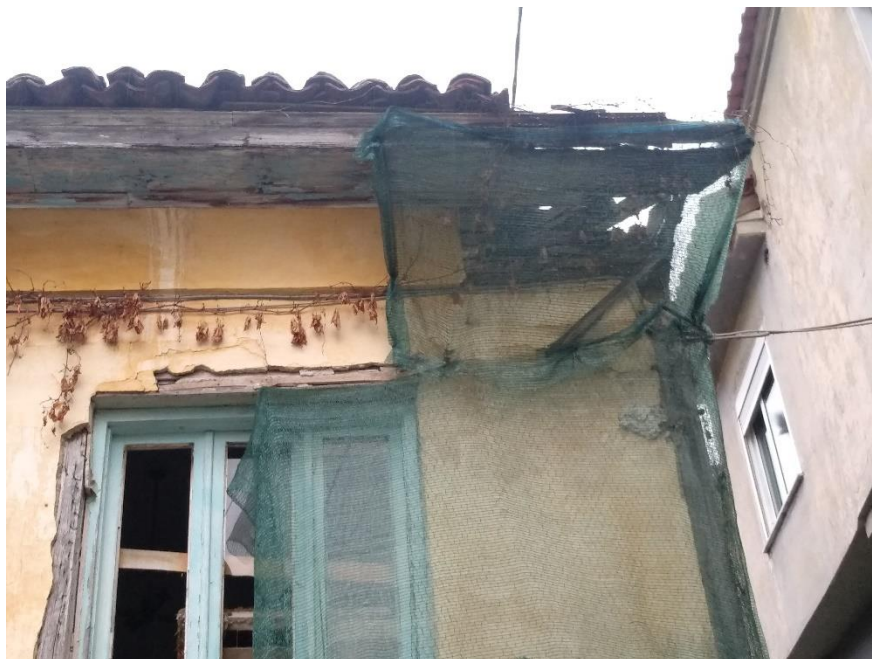
Φωτ. 4 Λεπτομέρεια της στέγης
